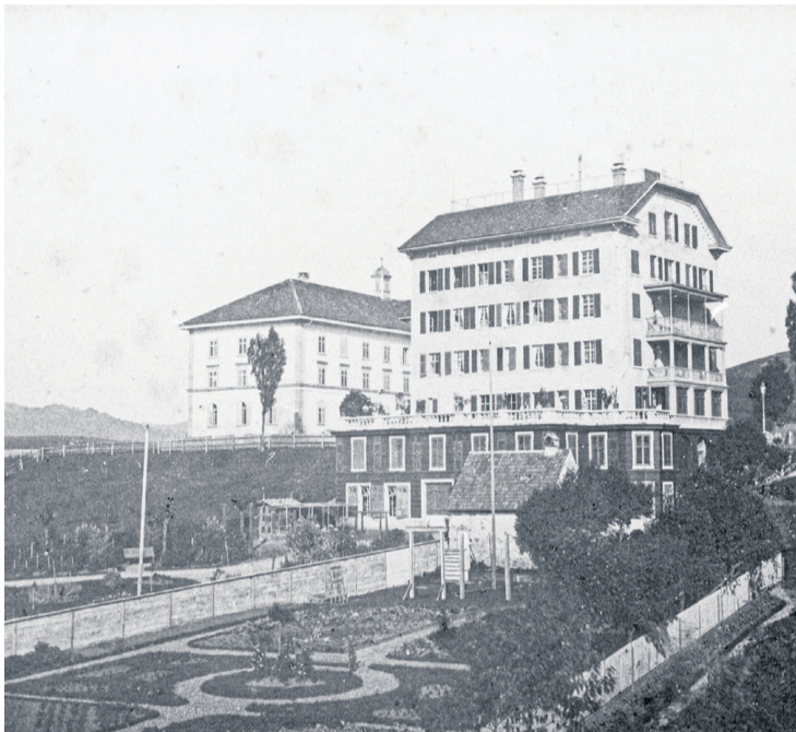
1900: Das Schloss von National- und Ständerat Nikolaus Benziger mit Anbau und schöner Gartenanlage. Dahinter das Alte Schulhaus.
