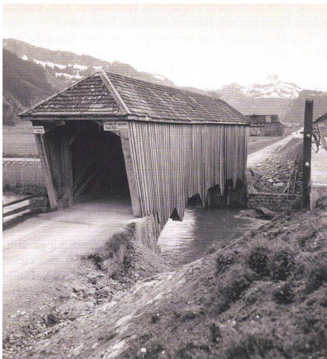
Abb. 7: Die alte Höhport-Brücke über die Sihl vor ihrem Abbruch 1936.
